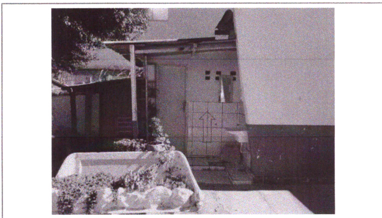
Figura 7 – Revestimento a serem removidos na Lavanderia
