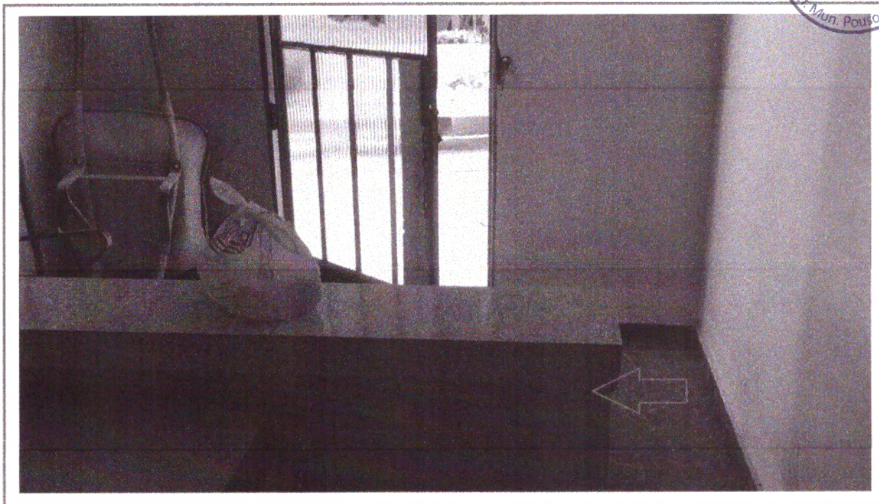
Figura 8 – Bancada a ser demolida
